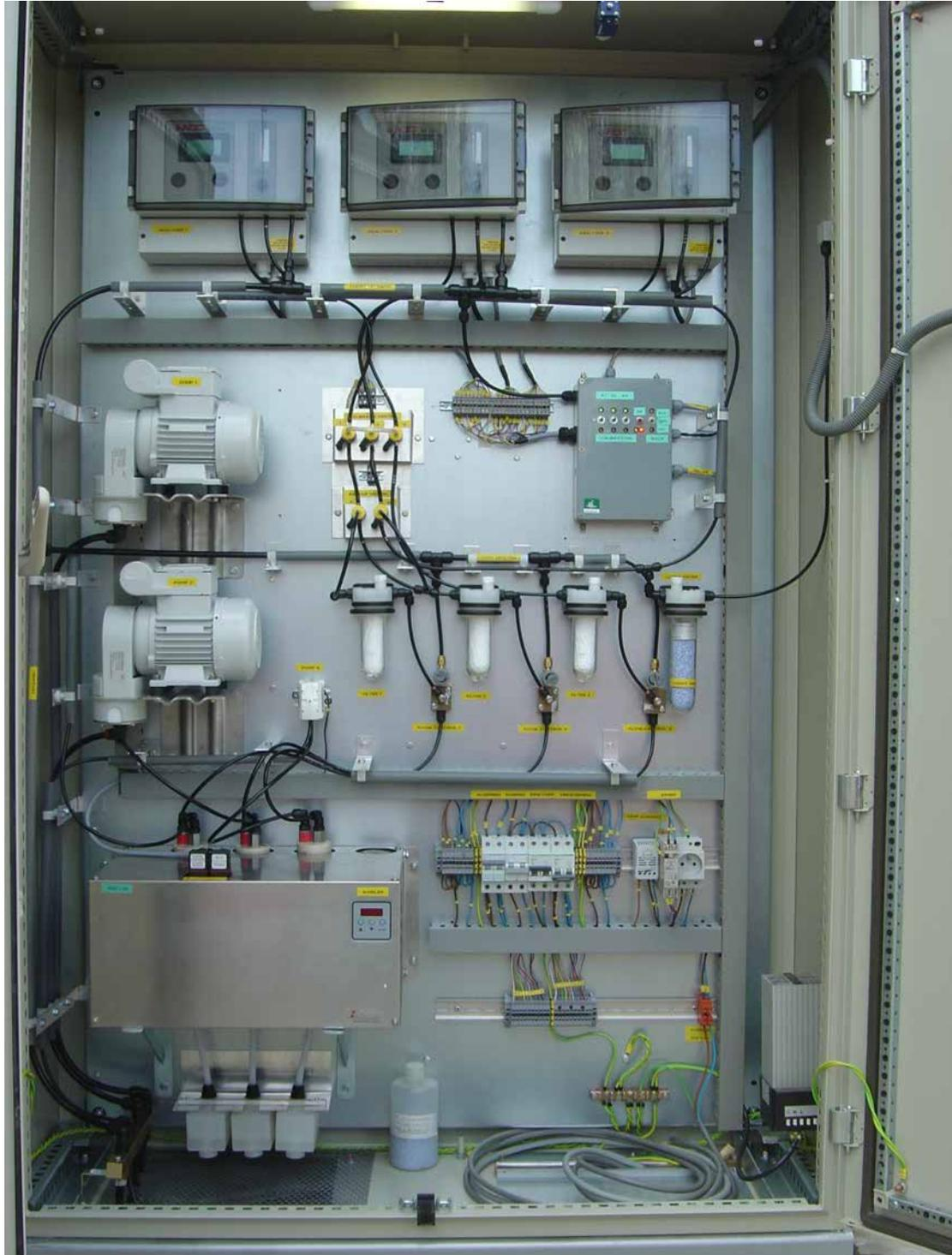
**Système d'analyse de CH<sub>4</sub> et H<sub>2</sub>S**
